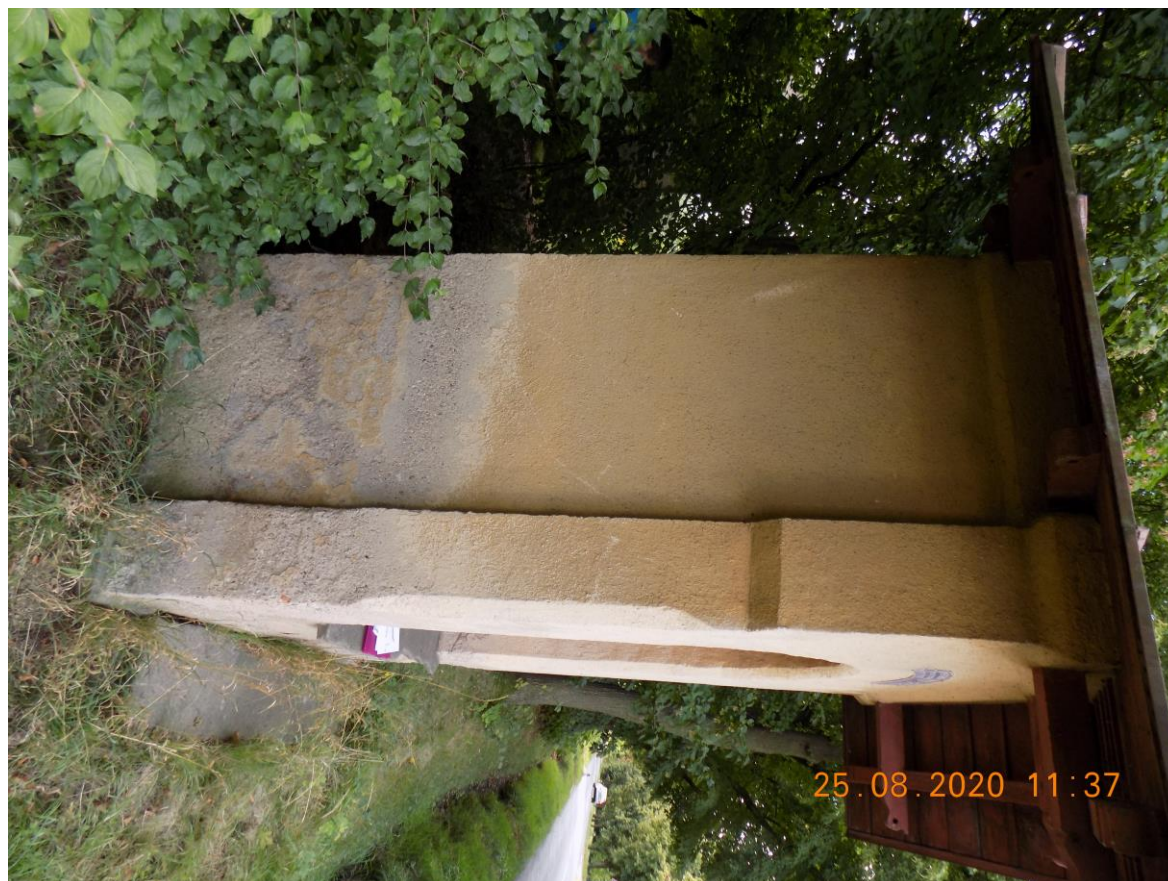
Foto č.3 Ľavý pohľad - silné degradovanie omietky v spodnej časti steny
