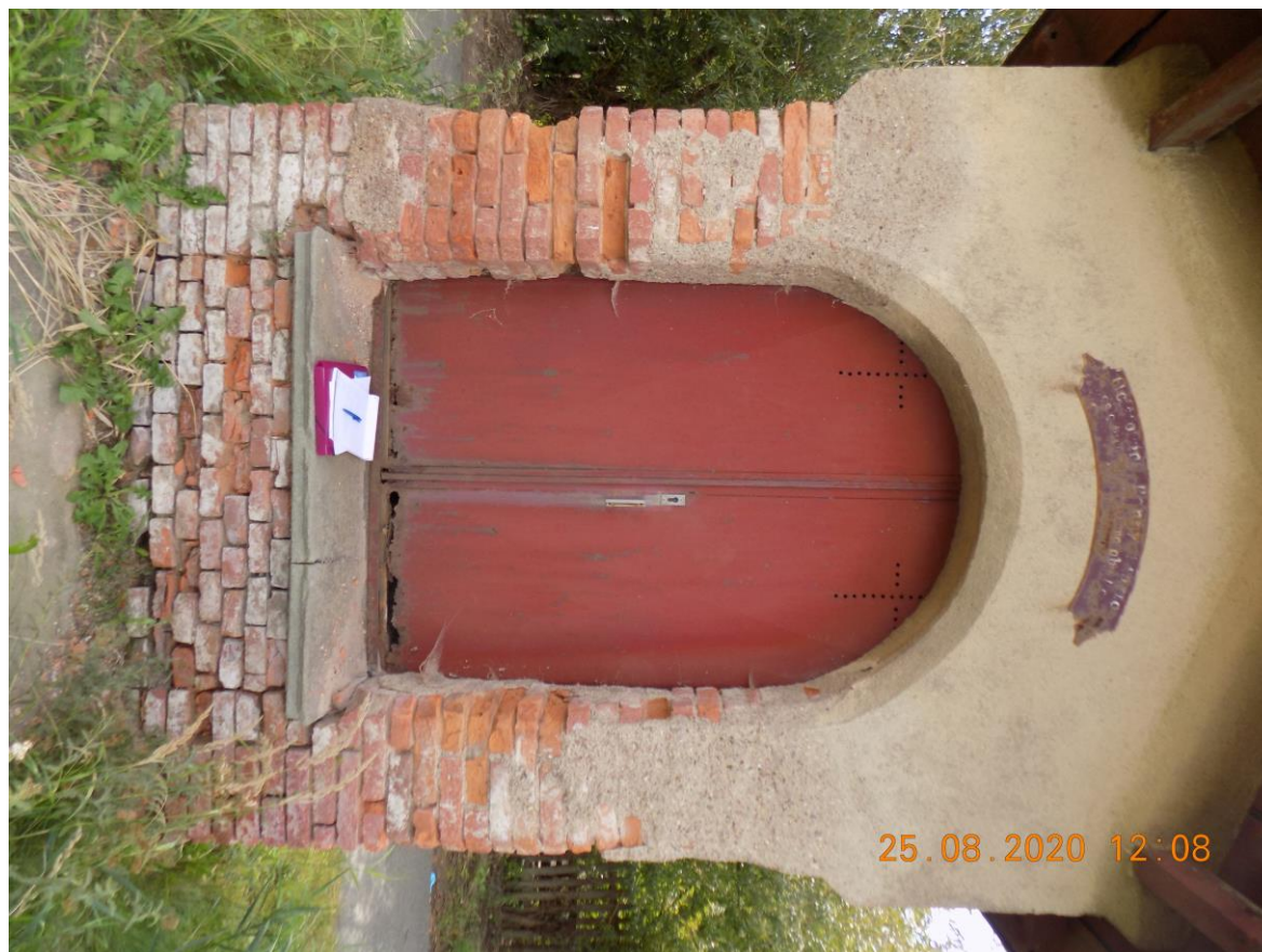
Foto č.1 Predný pohľad - veľmi silné degradovanie omietky a opadanie zvetraných tehál, trhlina v kamennej parapetnej doske
