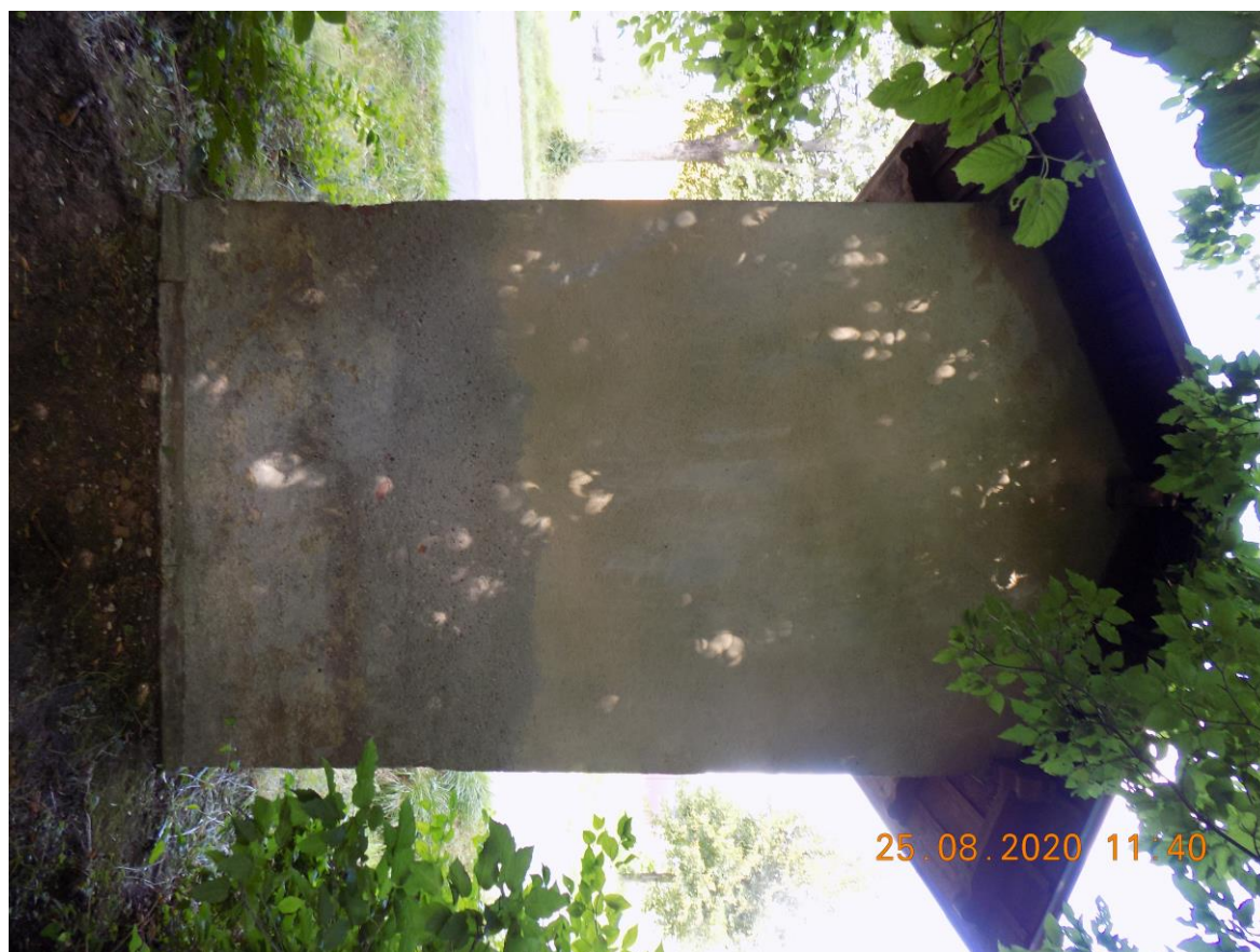
Foto č.2 Zadný pohľad - silné degradovanie omietky v spodnej časti steny
