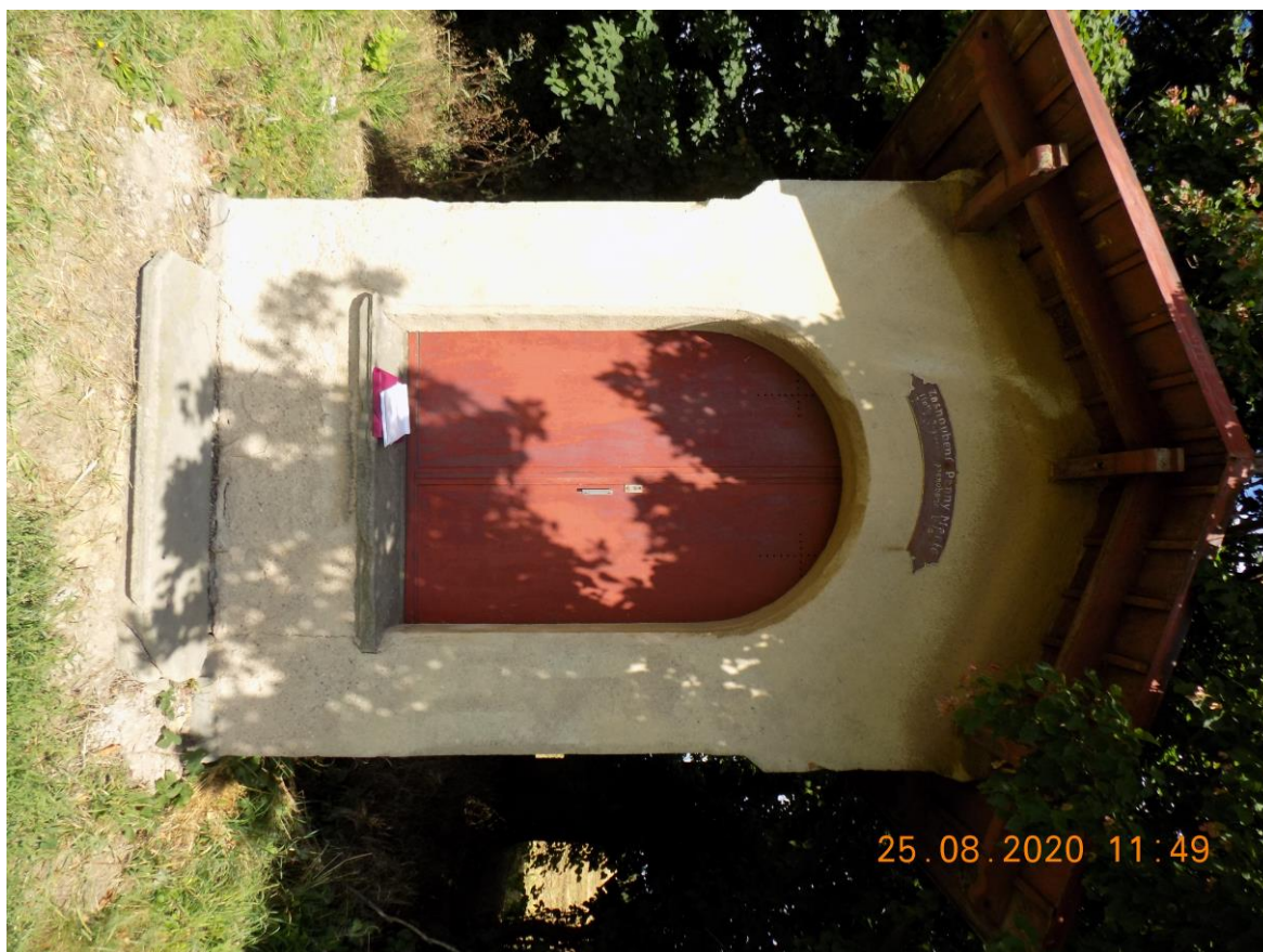
Foto č.1 Predný pohľad - slabé degradovanie omietky v spodnej časti steny a trhlina v pravom napojení parapetu na stenu
