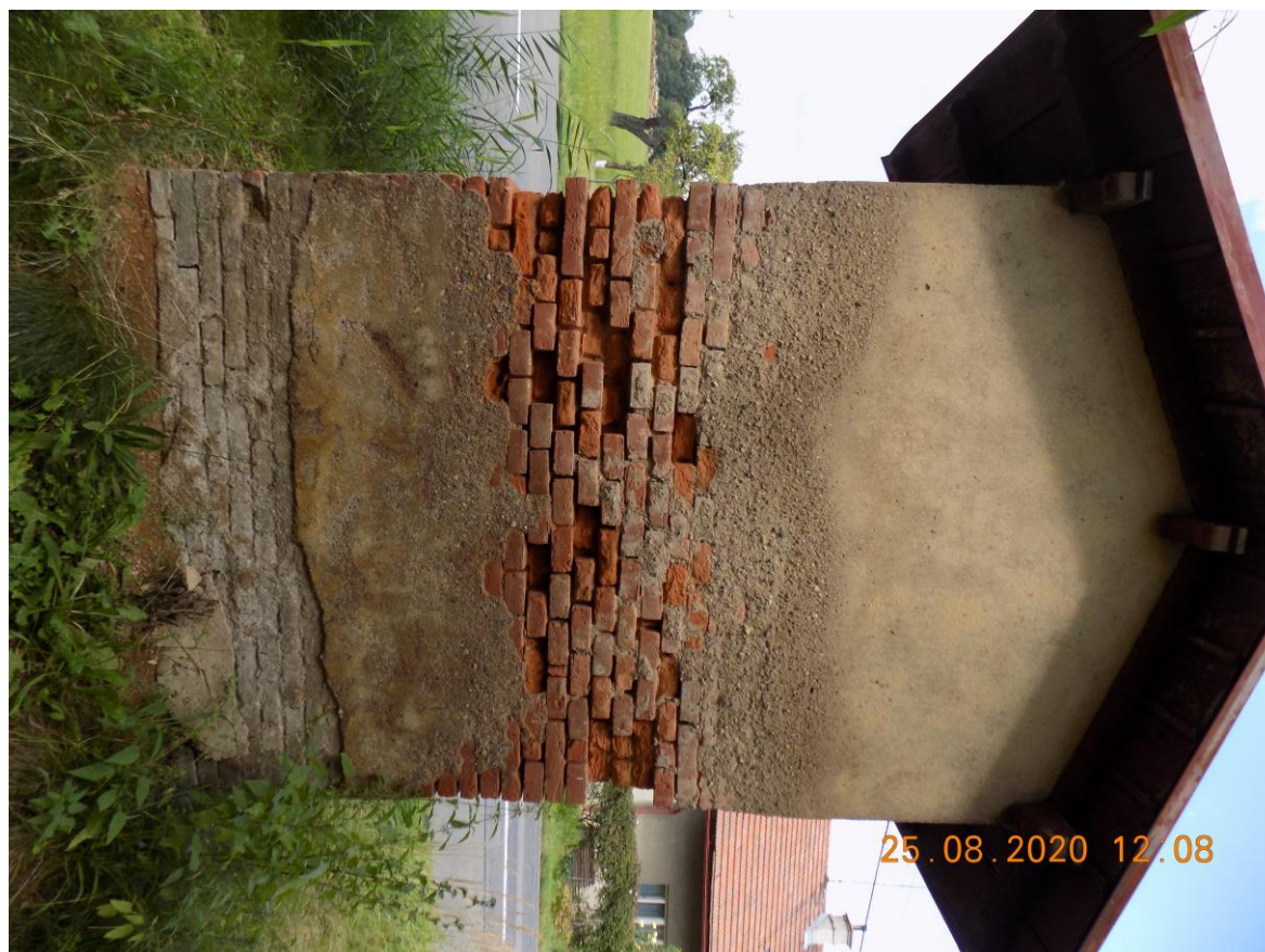
Foto č.2 Zadný pohľad - veľmi silné degradovanie omietky a opadanie zvetraných tehál
