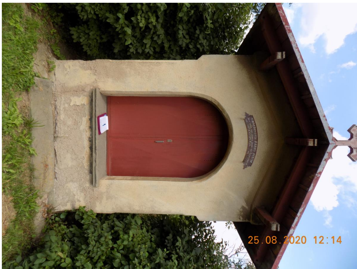
Foto č.1 Predný pohľad - slabé degradovanie omietky v spodnej časti steny a trhlina v ľavom kraji parapetu
