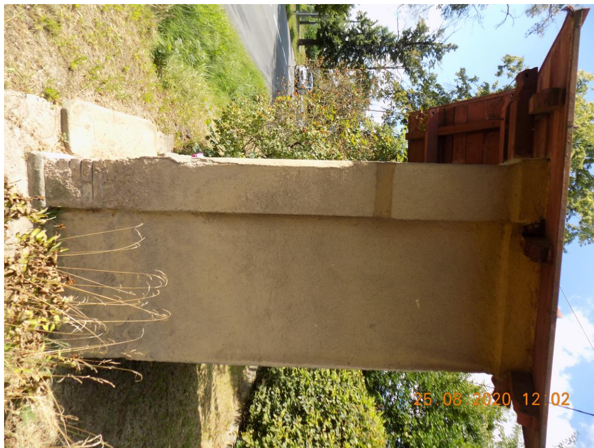
Foto č.4 Právý pohľad - silné degradovanie omietky v spodnej časti steny a jej opadanie
