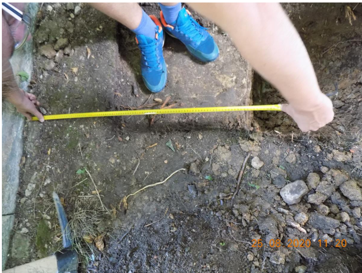
Foto č.3 Zmeranie vzdialenosti okraja založenia od steny kapličky
