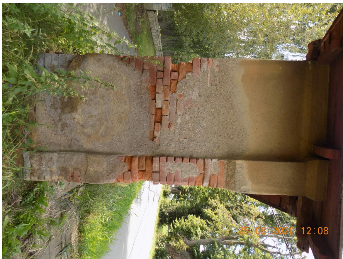
Foto č.4 Právý pohľad - veľmi silné degradovanie omietky a opadanie zvetraných tehál
