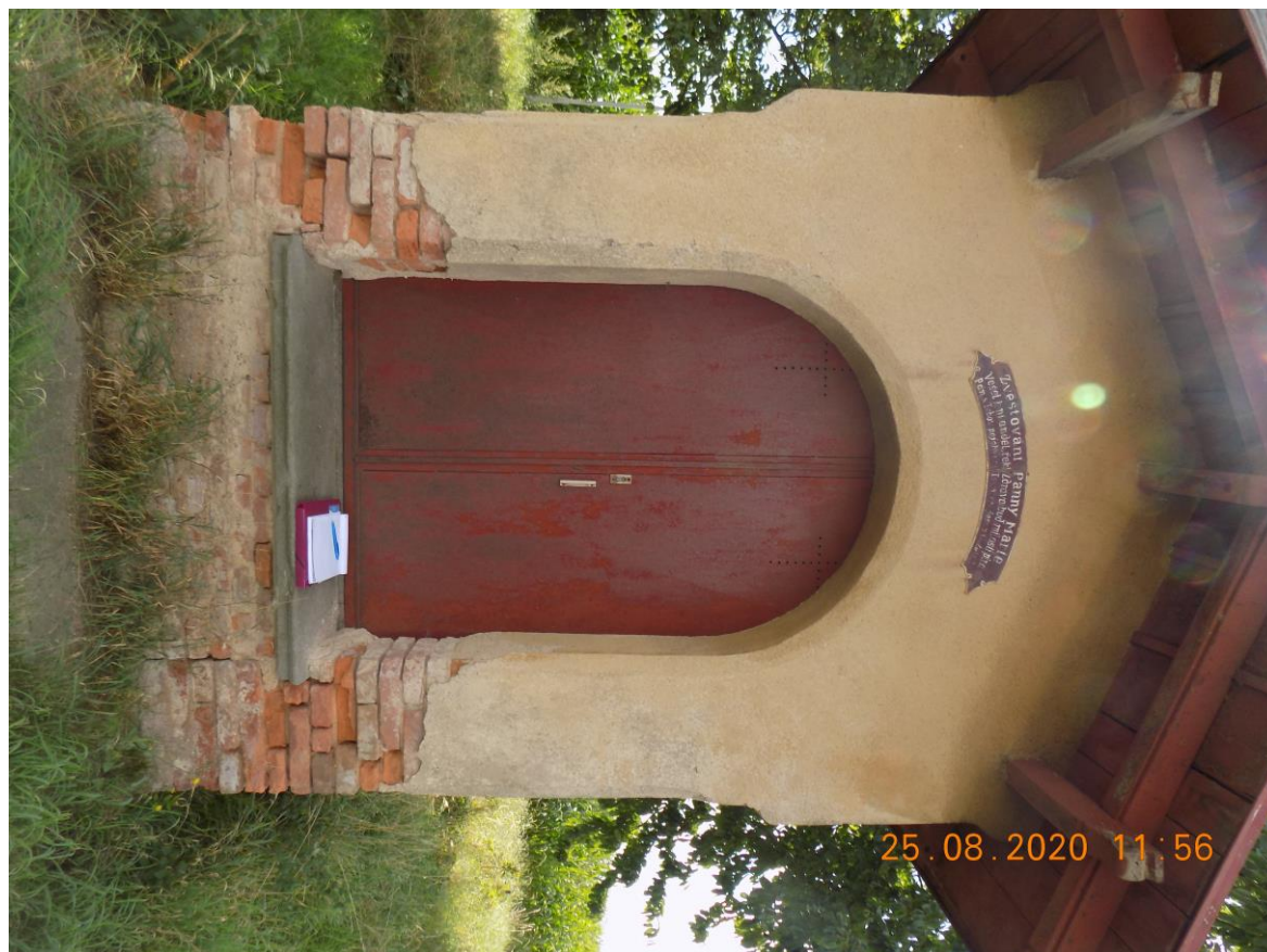
Foto č.1 Predný pohľad - silné degradovanie omietky v spodnej časti steny a opadanie zvetraných tehál v rohoch
