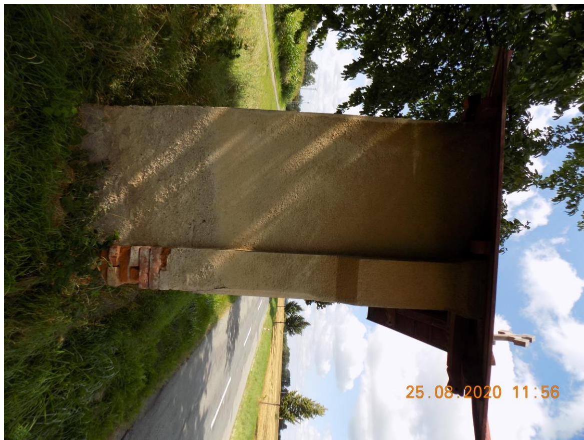
Foto č.3 Ľavý pohľad - silné degradovanie omietky v spodnej časti steny a jej opadanie
