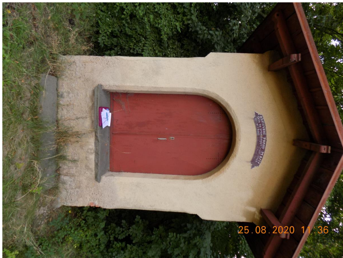
Foto č.1 Predný pohľad - silné degradovanie omietky v spodnej časti steny a opadanie na pravom rohu
