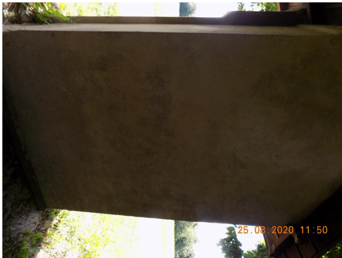
Foto č.2 Zadný pohľad - slabé degradovanie omietky v spodnej časti steny
