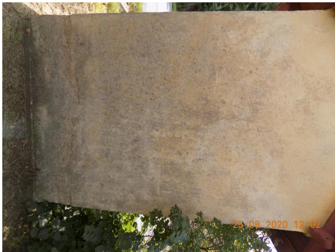
Foto č.2 Zadný pohľad - silné degradovanie omietky v spodnej časti steny a jej opadanie
