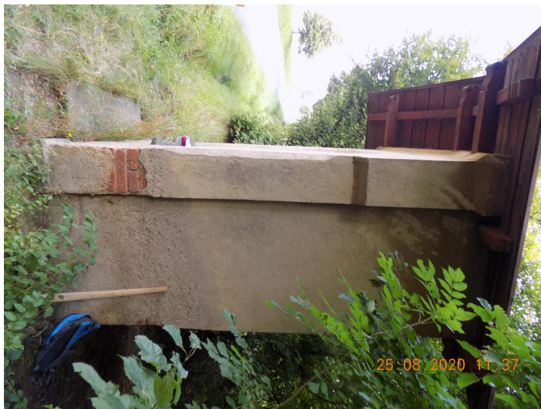
Foto č.4 Právý pohľad - silné degradovanie omietky v spodnej časti steny a opadanie v pravom rohu
