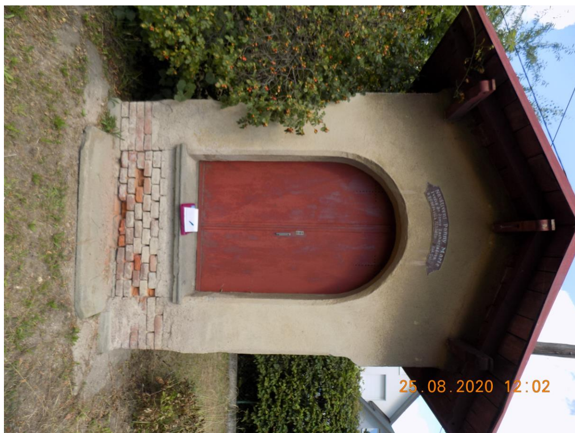
Foto č.1 Predný pohľad - silné degradovanie omietky v spodnej časti steny a opadanie a zvetraných tehál v parapete
