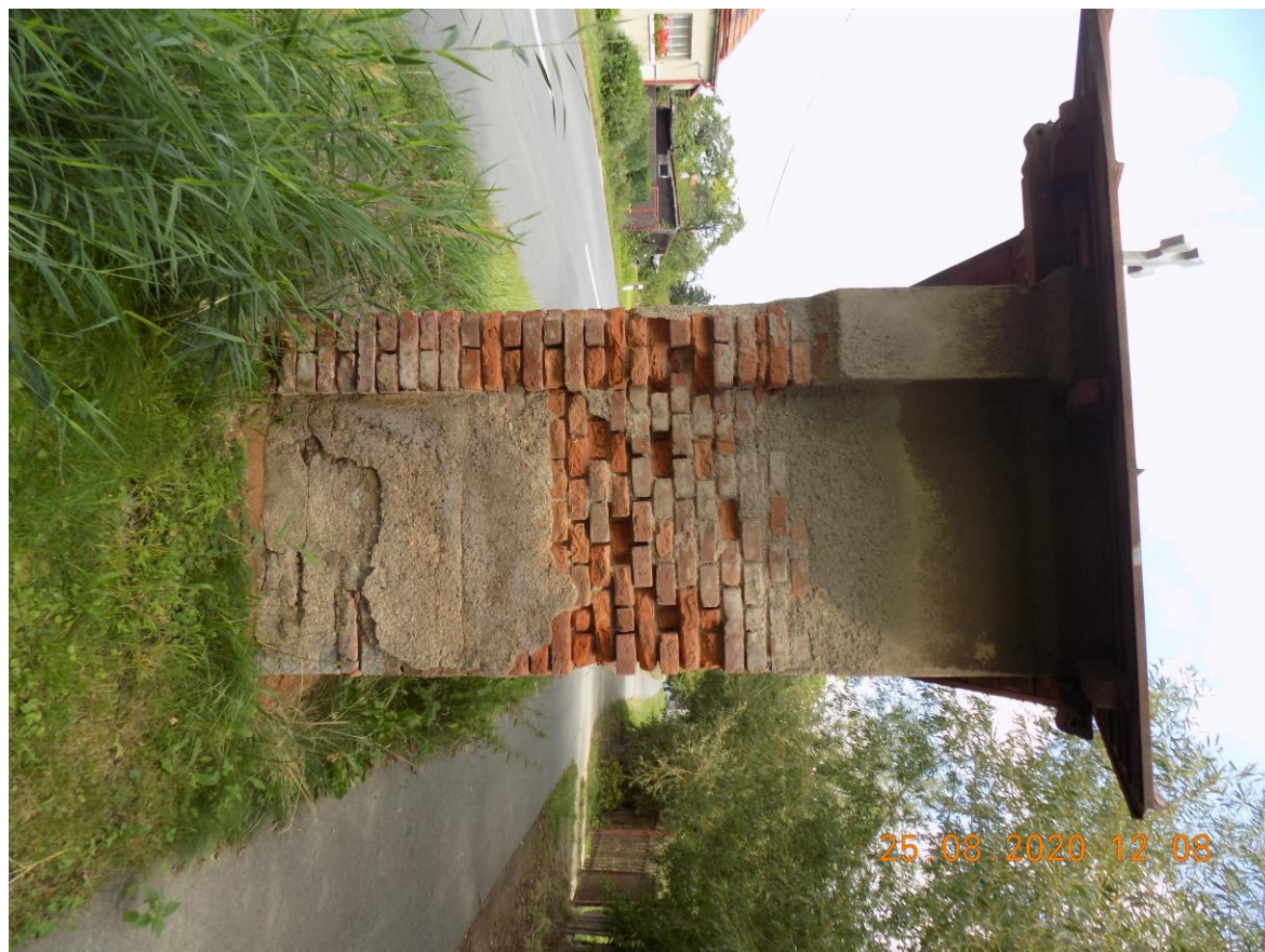
Foto č.3 Ľavý pohľad - veľmi silné degradovanie omietky a opadanie zvetraných tehál
